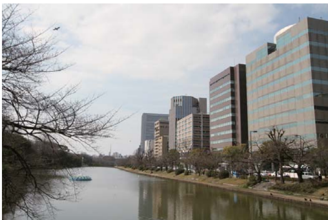
スカイラインが整ったビル群のイメージ
